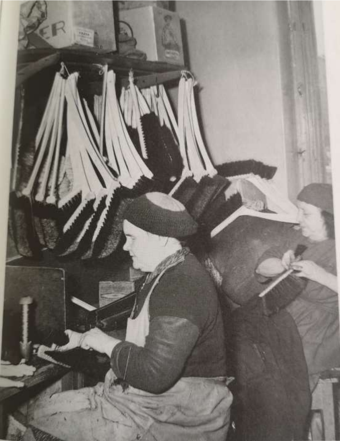
Harjapöytään kiinnitettyyn pulikkaan kieritettiin vyyhteinä tullut harjalanka. Pulikka toimi samalla langankiristäjänä. Myöhemmin lanka tuli valmiiksi rullalle kelattuna, joten yksi työvaihe jäi pois. Kuva Pengerkadun työverstaasta. (Näkövammaisten Keskusliitto ry)
